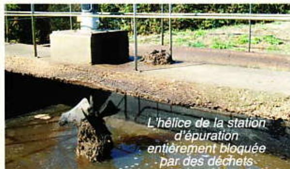
*L'hélice de la station d'épuration entièrement bloquée par des déchets*
