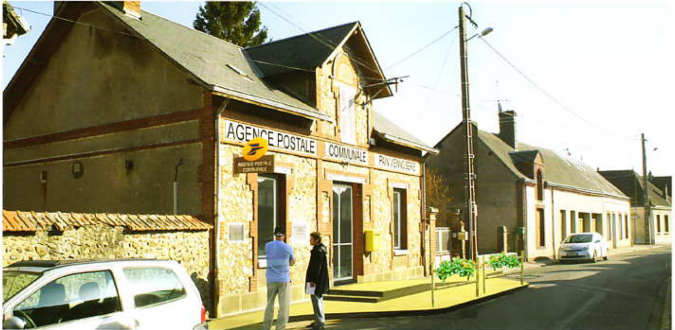
L'espace multiservices est en totale réfection
