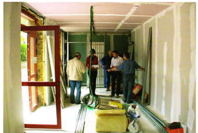
Réunion de chantier sur les travaux de l'espace multiservices qui avancent à grands pas.
