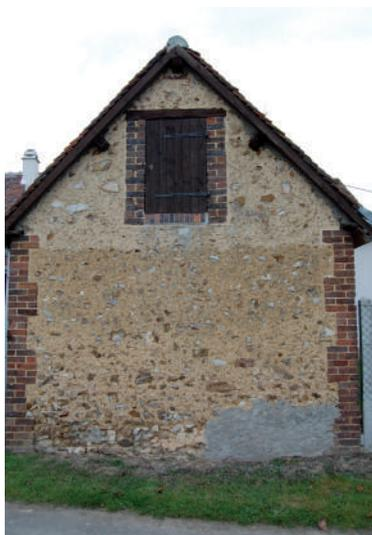
Bâti traditionnel percheron : mur en silex avec enduit au sable et chaînage d'angle en brique.
