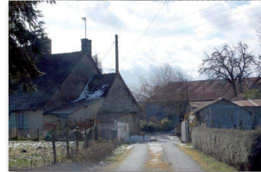
Figure 78 / Traditionnellement, les faîtages des annexes se situent dans le prolongement des faîtages du bâtiment principal et les pentes des bâtiments principaux varient autour de 50°.
